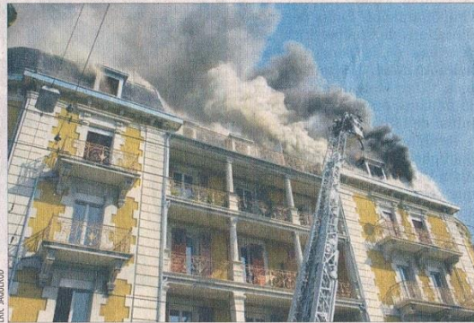
Les étages supérieurs ont été les plus touchés. Quant aux commerces et locaux administratifs situés au rez, ils ont subi des dégâts d'eau.
