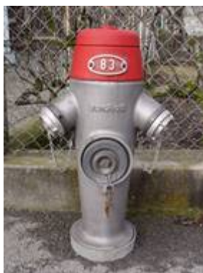
Type « VonRoll 5000 » 2 sorties latérales 55 mm 1 sortie centrale 75 mm
